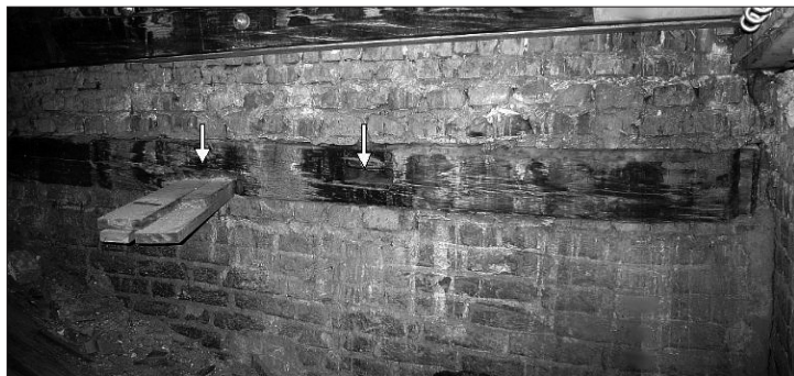
4. att. Iemūrētais šķautnis Doma baznīcas korpusa austrumu zelmiņa apakšējā daļā (ar bultiņām norādītas iecirsto ligzdu vietas)
