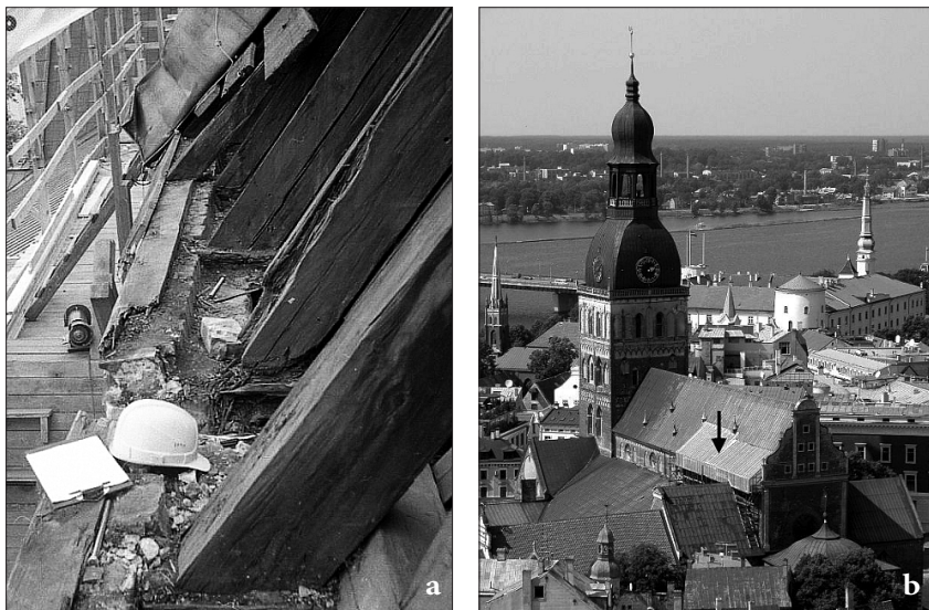
1. att. Dendrochronoloģiski datēto spāru gali pirms nomaiņas 2000. gadā (a) un to atrašanās vieta Doma baznīcas vidusjoma jumta dienvidu pusē (b) 3
